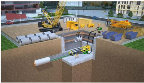
Le tecnologie NO-DIG, come il Microtunneling, offrono numerosi vantaggi rispetto alle tecniche di scavo tradizionali. Queste tecnologie garantiscono maggiore sicurezza per i lavoratori in cantiere, riducendo i rischi di franamento del fronte di scavo e di caduta dall'alto.
